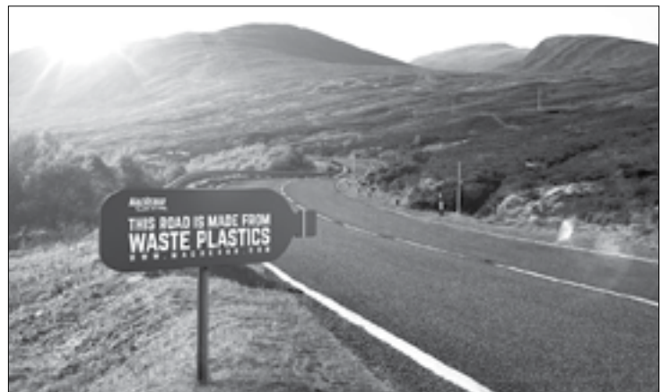
▲ Con đường sử dụng nhựa đường tái chế từ RTN của Công ty MacRebur
