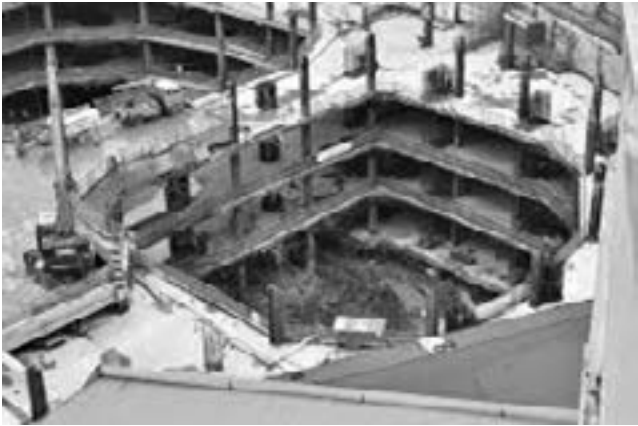
Hình 2. thi công tầng hầm công trình theo phương pháp semi top-down
