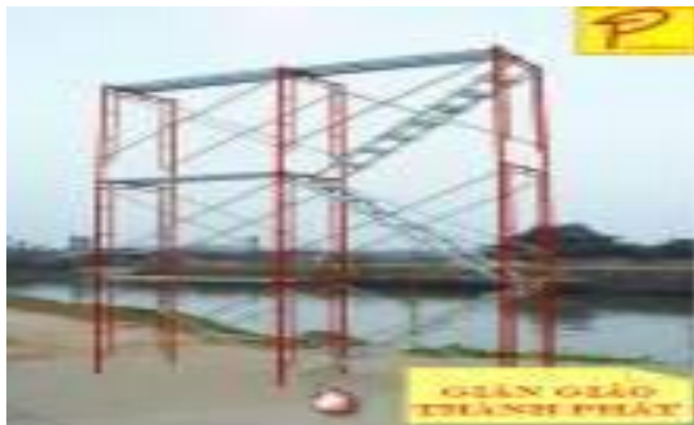
Hình 3 - 2 Giáo lắp ghép được lắp dựng
