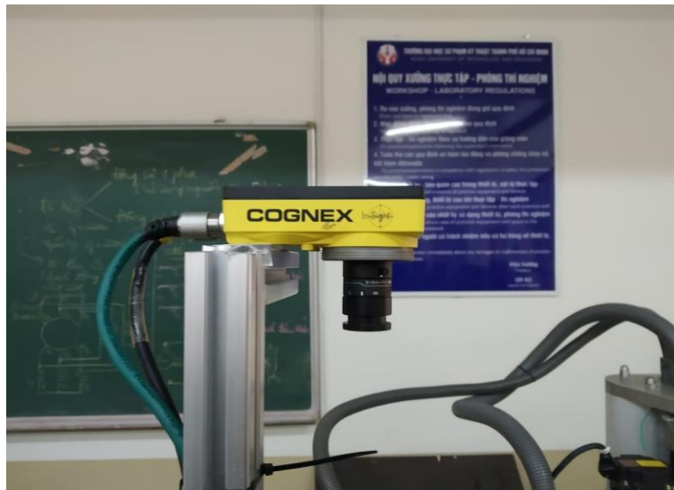
Hình 4. 9 Lắp đặt Camera
