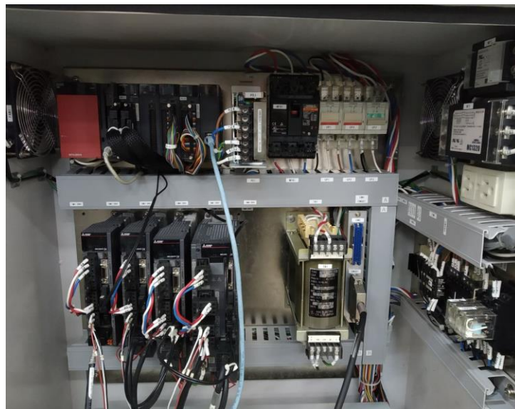
Hình 4.18 Lắp đặt thiết bị vô tủ điện
