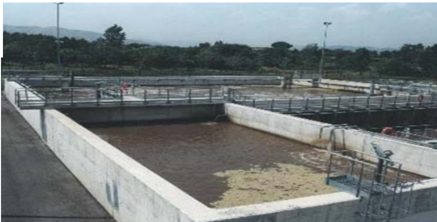
Hình 3.3. Bể điều hòa
