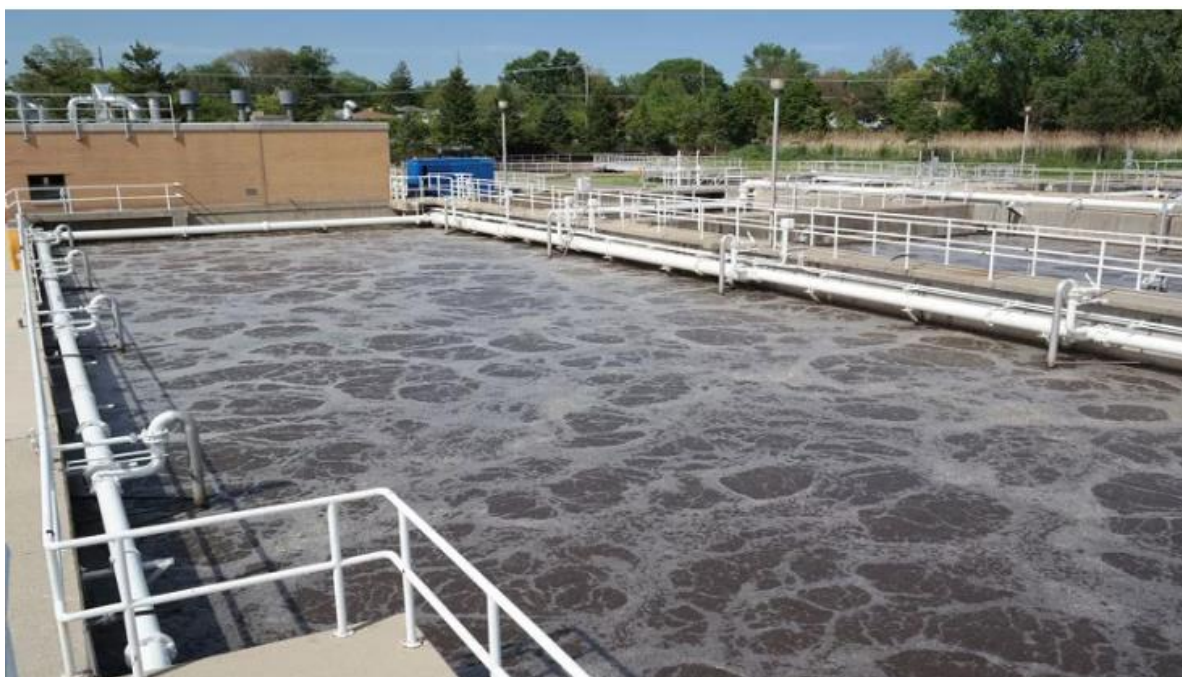
Hình 2.6: Bề mặt bể Aerotank
