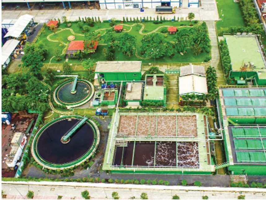
Hình 2.6: Hệ thống xử lý bia của nhà máy Heineken tại TP.HCM
