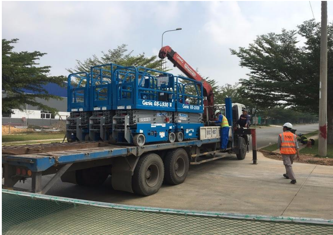
Hình 5. 5. Thực hiện cầu nâng hạ xe nâng xuống công trường.
