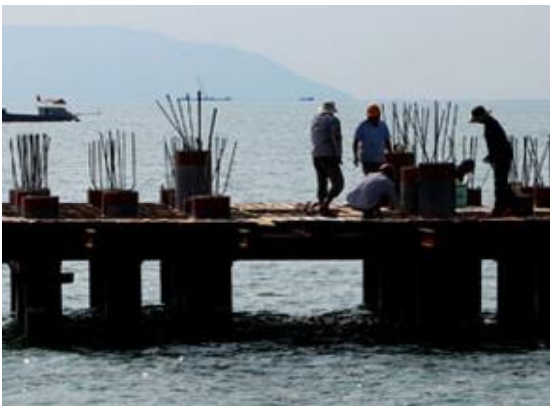
Hình 1.3. Thi công móng Dự án đưa điện ra xã đảo Lại Sơn, Kiên Hải
