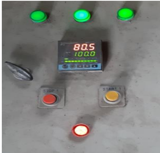
Hình 3.14. Thiết bị kiểm tra nhiệt độ quá trình dưỡng hộ nhiệt.
