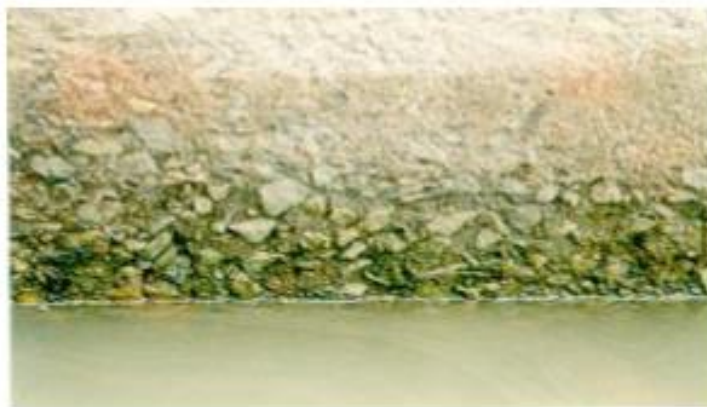
Hình 1.3: Cống Cầu Tàu - Bến Tre, sau 12 năm sử dụng [2]
