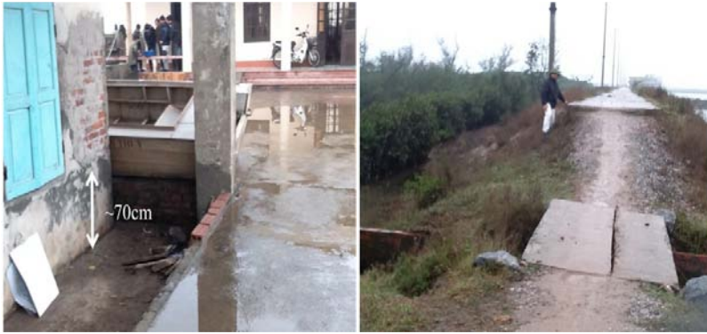
Hình 4.8. Mực nước biển những ngày triều cường sau năm 2000 dâng cao hơn trước đó khoảng 70cm. Trạm Kiểm lâm phải xây dựng lại nhà mới có nền nhà cao hơn trước (phải) và đê biển cũng phải tôn cao lên (trái) (Ảnh chụp tháng 12 năm 2011)
