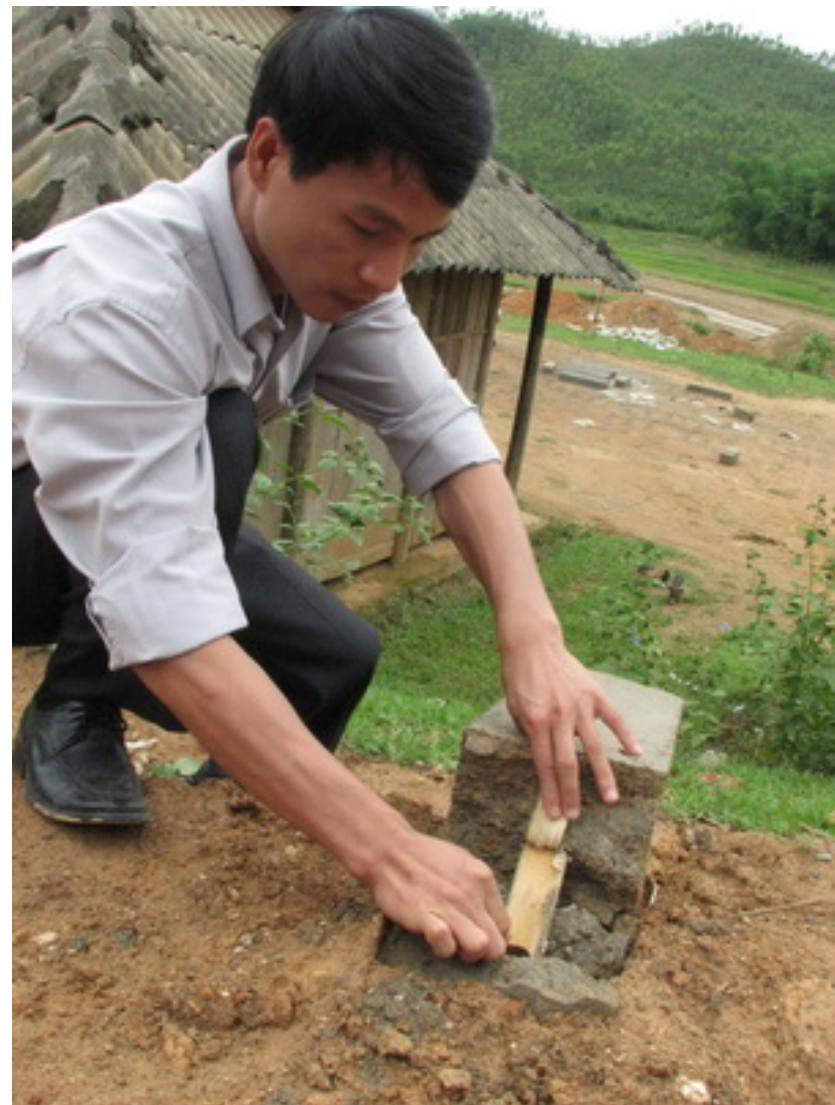
Cọc tiêu bằng Bê tông cốt tre
