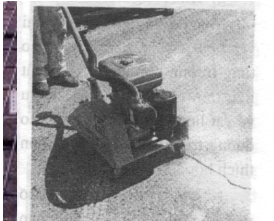
Máy cắt vết nứt bê tông xi măng.
