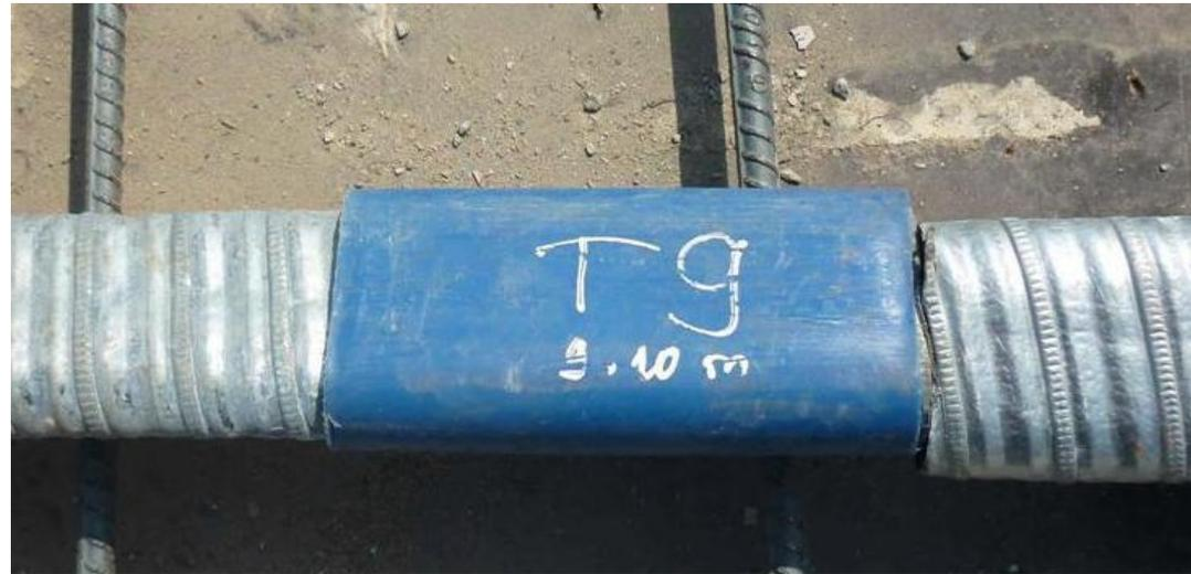
*Hình 2.12. Ống nối bằng nhựa + băng dính*
